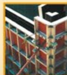
Assemblage par bloc variable des fourrures sur angle extérieur.
